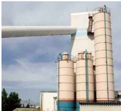
● セメント・建設資材
